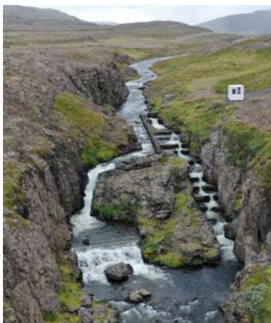
Mynd 4. Fiskvegur í Laugardalsá í Ísafjarðardjúpi (vinstri) og teljarabrep í Langadalsá í Ísafjarðardjúpi (hægri).
