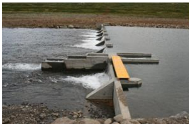
Mynd 4. Fiskvegur í Laugardalsá í Ísafjarðardjúpi (vinstri) og teljarabrep í Langadalsá í Ísafjarðardjúpi (hægri).
