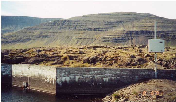
Mynd 1. Árvaka fiskteljari í fiskvegi í Eyrarfossi í Laxá í Leirársveit. Myndin er tekin í júní 2001.
