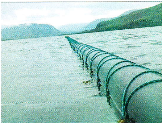
Mynd 2.15. Röralína í Hvammsvík sumarið 2001.
