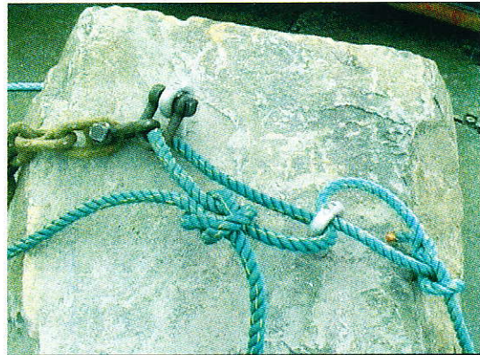
Mynd 2.2. Tveir augnboltar hafa verið reknir niður í grjótið. Annar er til að festa keðju og hinn til að festa tóg með belg sem tekið er í þegar færa á steinininn. Band sem er fest í báða augnbolta er notað til að hýfa grjótið frá borði.
