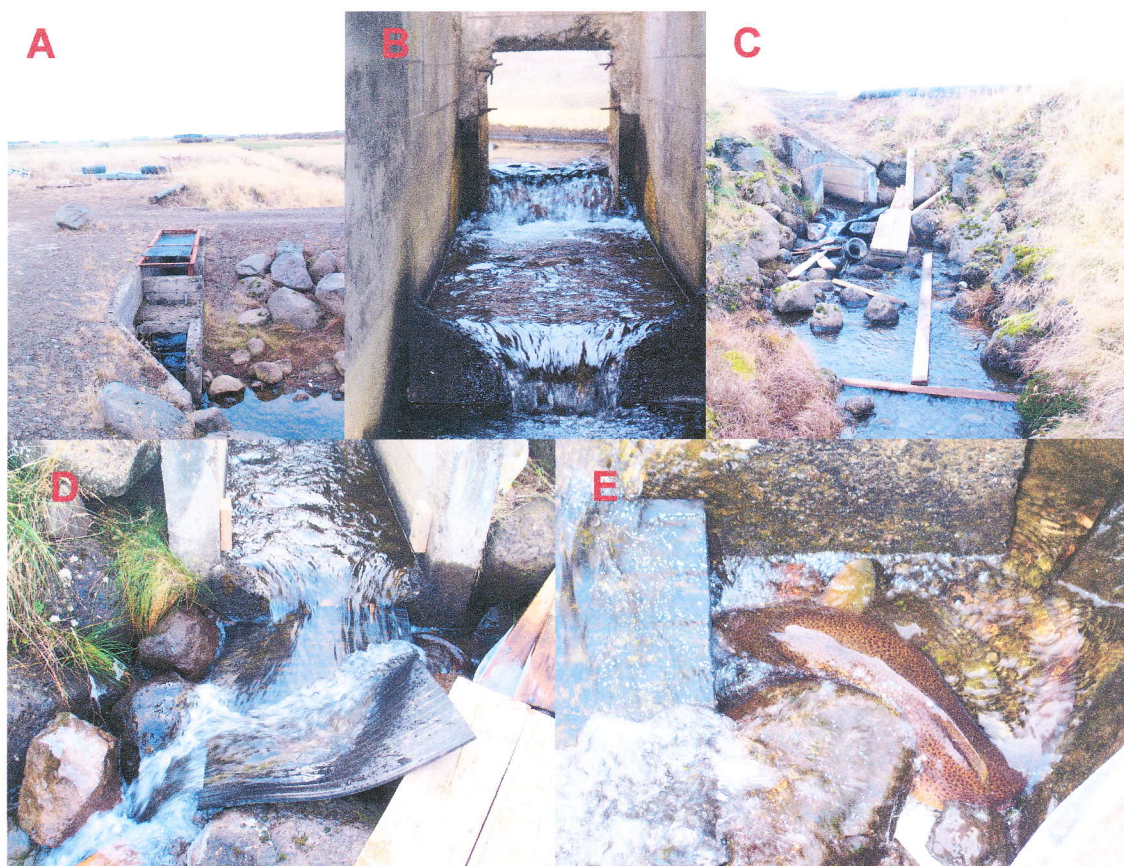
Mynd 12. Stokkur/hindrun í Stórakrókslæk. A) stokkurinn séður ofan frá. B) séð upp í gegnum stokkinn. C) stokkurinn séður neðan frá. D) útfall úr stokknum. E) hrygningarurriði í ógöngum fyrir neðan stokkinn.
