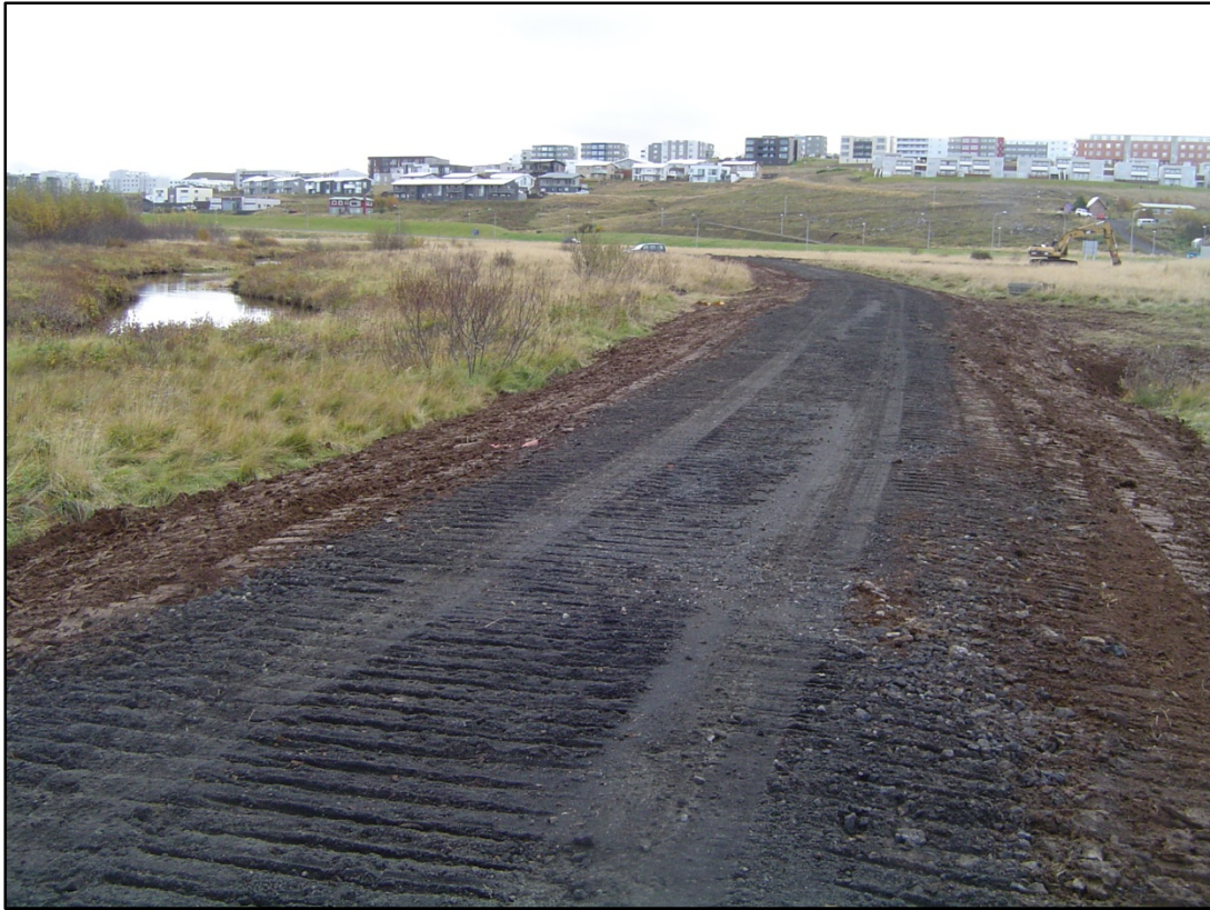
Unnið að gerð uppbyggðs og malbikaðs göngustígs meðfram Úlfarsá rétt ofan við Vesturlandsveg. (Ljós. Friðþjófur Árnason)
