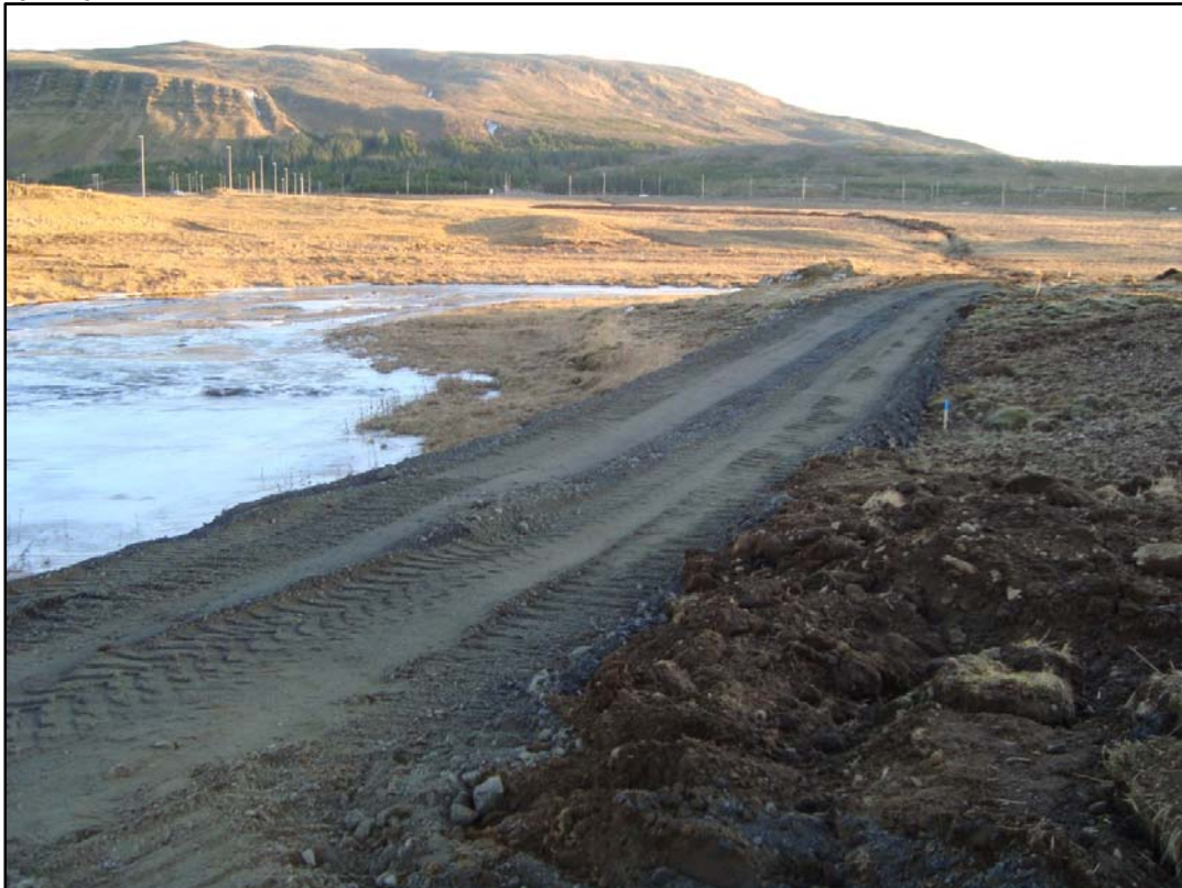
Uppbyggður vegaslóði sem gerður var vegna framkvæmda við golfvöllinn við Korpúlfsstaði. (Ljósm. Friðbjófur Árnason)
