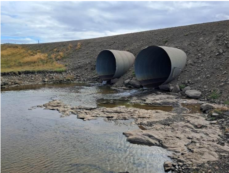
B) Leitisá á Skógarströnd. Hægra ræsið (frá vegi séð) er með um 21 cm stall sem er erfið hæð fyrir seiði. Rennsli úr vinstra ræsi rennur beint á klöpp og er líklega gengt fyrir allar stærðir fiska. Straumur og dýpi hæfilegt.
