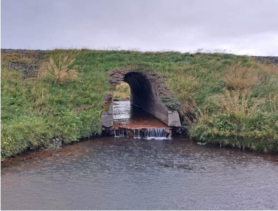
l) Vörðufellslækur. Steypt bogræsi með um 20 cm háan stall neðan við það. Dýpi lítið í ræsi. Þyrfti að skipta út.
