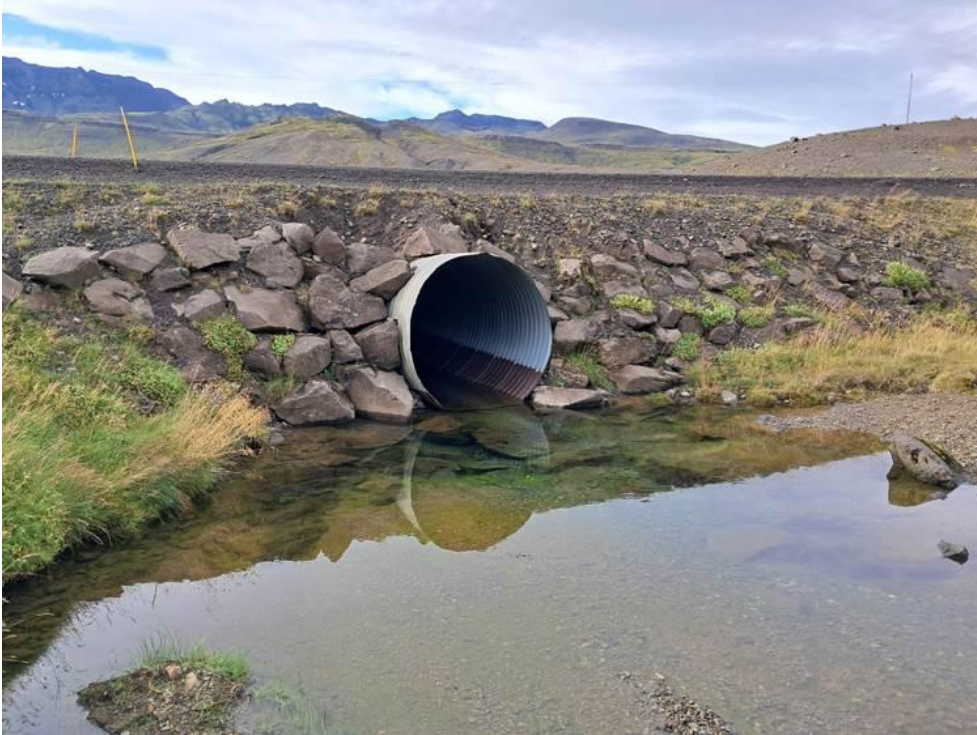
E) Hnappá í Álftafirði. Vel sett ræsi, enginn stallur, dýpi gott og rólegur straumur. Hylur neðan við ræsið. Bleikjuseiði neðan við ræsið.
