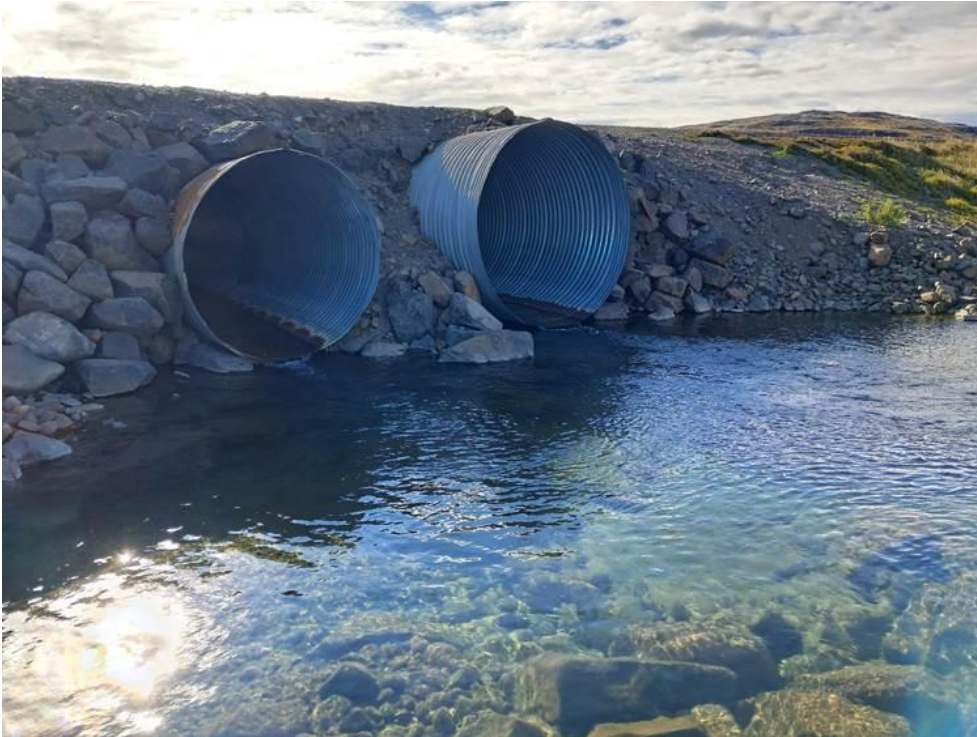
C) Bakkaá á Skógarströnd. Vel sett ræsi. Við hægra ræsið (frá vegi séð) er um 10 cm stallur og dýpi undir um 40 cm en enginn stallur er við vinstra ræsið. Straumhraði og dýpi gott. Djúpur hylur neðan ræsa.
