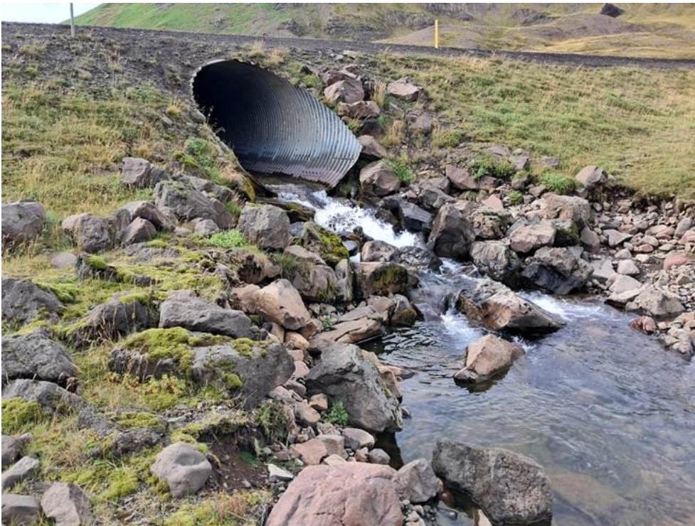
F) Úlfarsfellsá í Álftafirði. Hár stallur neðan við ræsi með stórgrýti. Hæðarmunur frá ræsi í hyl fyrir neðan 1,5 – 2 m. Gæti verið erfitt uppgöngu. Seiði fundust bæði ofan og neðan við það.
