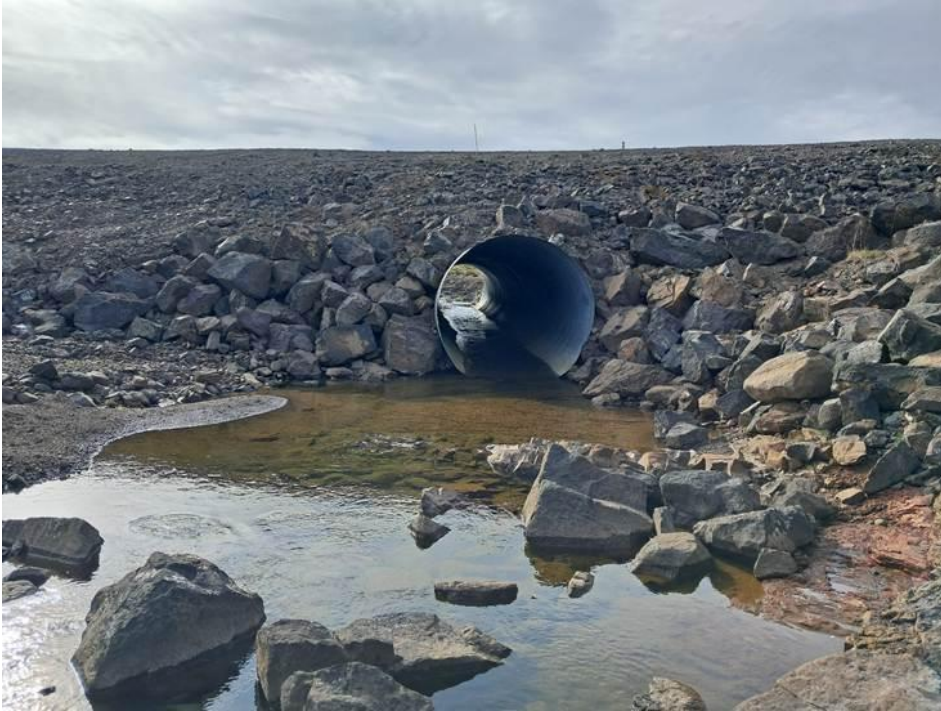
A) Gljúfurá/Gunnarsstaðaá á Skógarströnd. Nýlegt ræsi með rólegu rennsli í gegn og ágætis dýpi og enginn stallur við enda þess.
