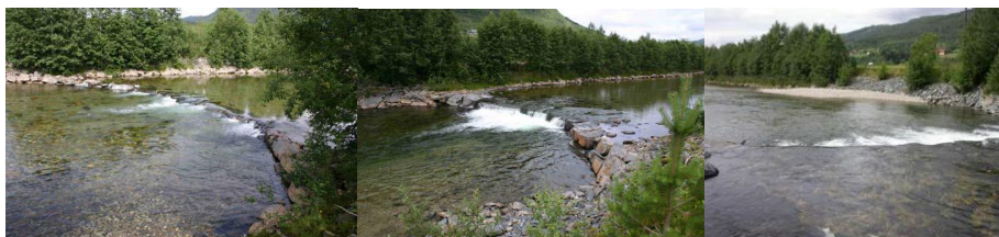
Mynd 6. Leiðigarðar úr grjóti og aðlögun farvegar að bergvatnsrennsli. Myndin lýsir mögulegri útfærslu á tilraunakafli. Leiðigarðar liggja frá landi og upp með straumi, að hluta, þannig að uppistaða vatns myndist. Straumstefna árinna er frá vinstri til hægri eins og bláa örin sýnir.
