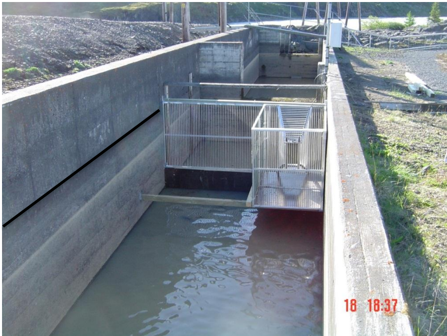
2. mynd. Gildrubúnaður og fiskteljari í fiskstiganum við Lagarfoss (horft er niður eftir fiskstiganum). Fiskur á leið upp á enga leið nema inn um gildrubúrs, en þar er fiskteljari staðsettur. Á vegg fiskstigans er sýnd svört lína sem gefur hugmynd um vatnshæð þegar stigin er í virkni. (Ljós. Ingi Rúnar Jónsson ).
