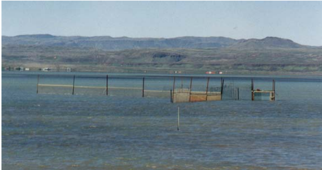
Mynd 4. Gildrumannvirki 2002. Þegar þessi mynd var tekin átti eftir að framlengja leiðara. Það var gert með 1,5 m háu vírneti, sem bætt var við hvorn enda hans.
