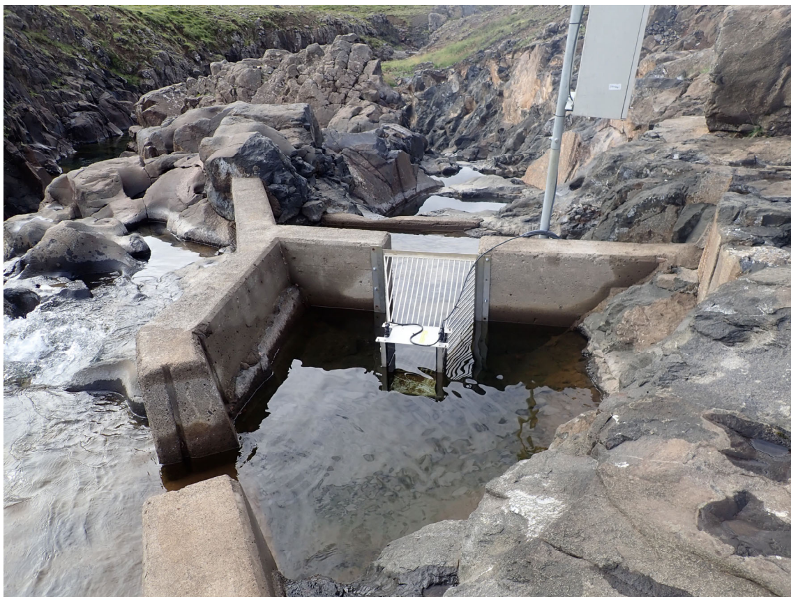
14. mynd. Fiskvegur við Sólheimafoss í Laxá í Dölum 7. september 2021. Ekki rann á milli þrepa í fiskveginum vegna lágrar vatnsstöðu. Ljósmynd Ásta Kristín Guðmundsdóttir.
