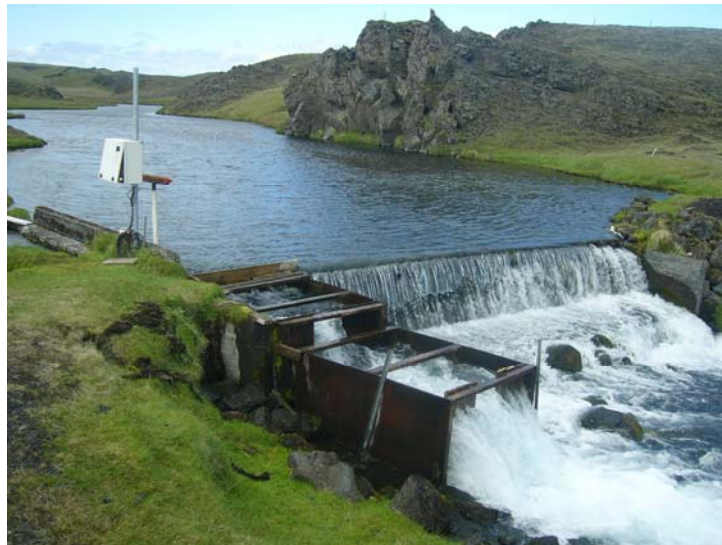
2. mynd. Fiskteljari í Grenlæk, við rafstöðvarstíflu í landi Seglbúða.
