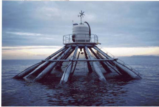
Mynd 2.5. Farmocean, Platform 4500 úthafskví á vegum Sjókvíar hf. utan við Vatnsleysuvík á Reykjanesi (Ljósmynd: Valdimar Ingi Gunnarsson).
