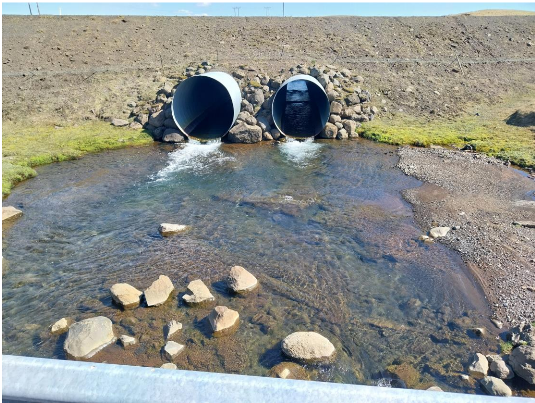
Mynd 7. Árkafli Kálfá ÓIII endar við vegræsi við Skáldabúðir. Vatnið fellur lóðrétt frá neðri endar ræsis en slíkar aðstæður skapa gönguhindrun.
