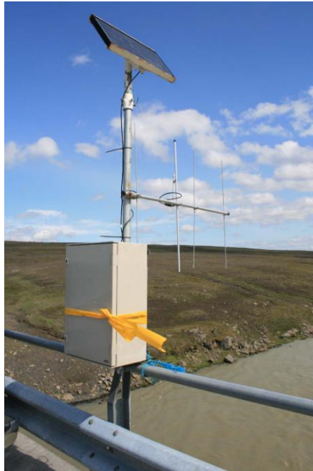
2. ljósmynd. Leitarstöð á brú yfir Tungnaá við Hald.
