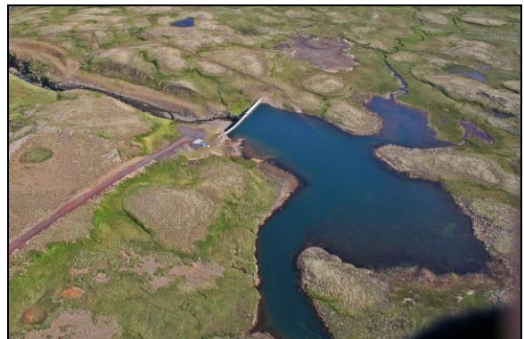
Stífla í útfalli Baulárvallavatns sem er inntak Múlavirkjunar í Straumfjarðará (Mynd: Sigurður Már Einarsson)
