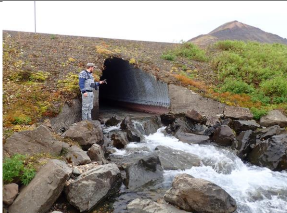
O) Kafli 17. Jóhannes Guðbrandsson stendur við ræsi í Tunguá, sem er ófiskgengt seiðum.
