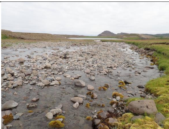
O) Kafli 10. Horft niður Álfsteinsá neðan þjóðveg, Horft er til ármóta hvar sér í inntakslón Andakílsárvirkjunar.
