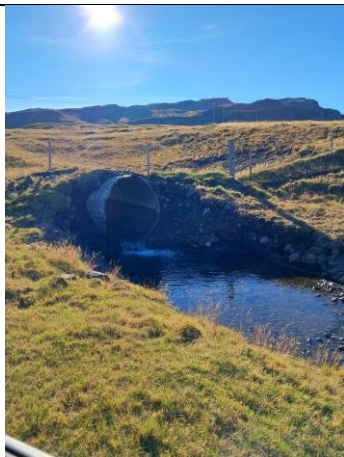
G) Kafli 13. Ræsi í Bæjarlæk, ofan við þjóðveg. Fiskgengi þess þarf að laga. Myndina tók Jóhannes Guðbrandsson.
