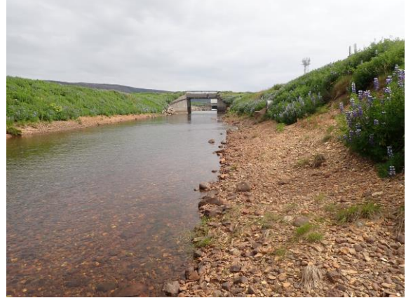
B) Kafli 2. Andakílsá er veitt eftir veituskurði úr Skorradalsvatni. Horft er upp að brú við þjóðveg hvar sést í stíflumannvirkið.
