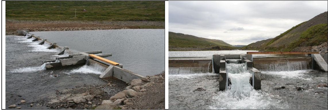
2. mynd. Fyrirstöðuprep í Langadalsá (til vinstri). Uppgangur að fiskteljarahólfi (til hægri). Ljósmyndir Ingi Rúnar Jónsson. Figure 2. The fish counting threshold in River Langadalsá (left) and entrance to the fish counting chamber (right). Photos by Ingi Rúnar Jónsson.
