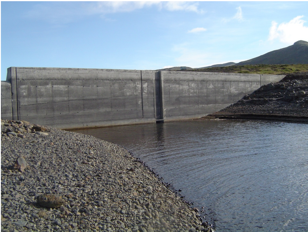
Stífla í útfalli Hraunsfjarðarvatns, lág vatnsstaða (mynd Friðbjófur Árnason).
