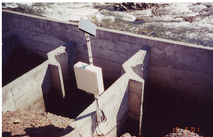
1. mynd. Árvaka fiskteljari í fiskvegi í Kambsfossi í Austurá. Myndin er tekin í júní 2001.
